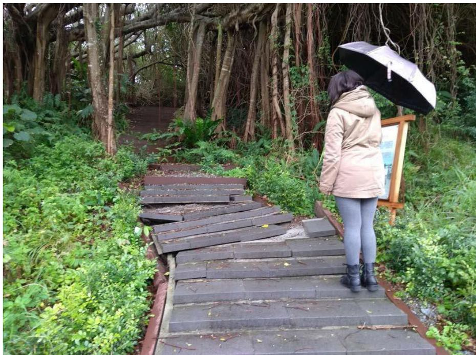
圖 16 七星山西側步道之破裂(摘自中央地質調查所, 2018)。照片中可見步道遭左移錯動約 70 公分，向東拍攝。
