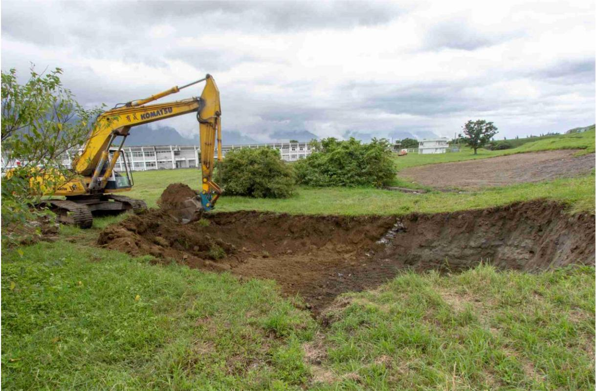
圖 39 槽溝開挖過程
