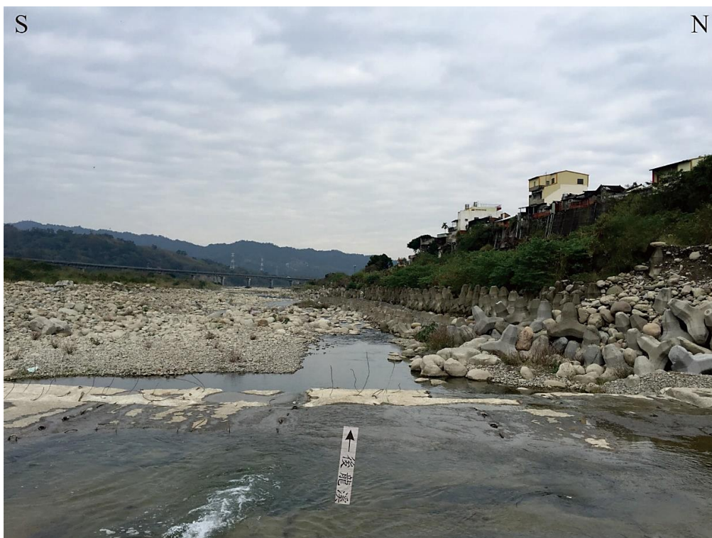
圖 39 後龍溪北岸為防波堤覆蓋未見岩層出露。自露頭 HL-7 處向西拍攝，露頭位置參照圖 31。
