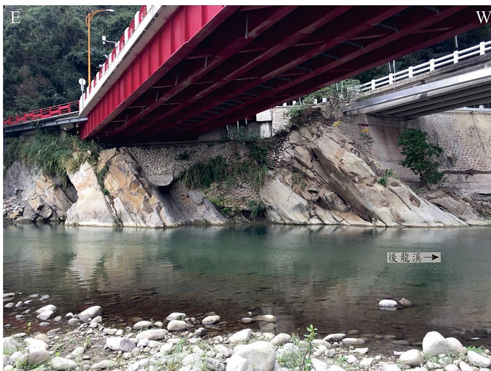
圖 33 出磺坑橋下方出露青灰色至灰白色厚層砂岩。根據出露位置及岩性，於露頭 HL-8 出露(位置參照圖 31)之厚層塊狀砂岩應為北寮砂岩。
