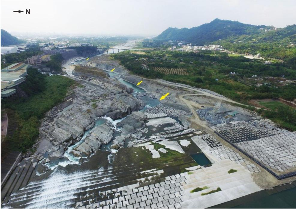
圖 55 石岡壩前緣大甲溪河床空照圖。石岡壩前沖蝕出一條河道(黃色箭頭處)。
