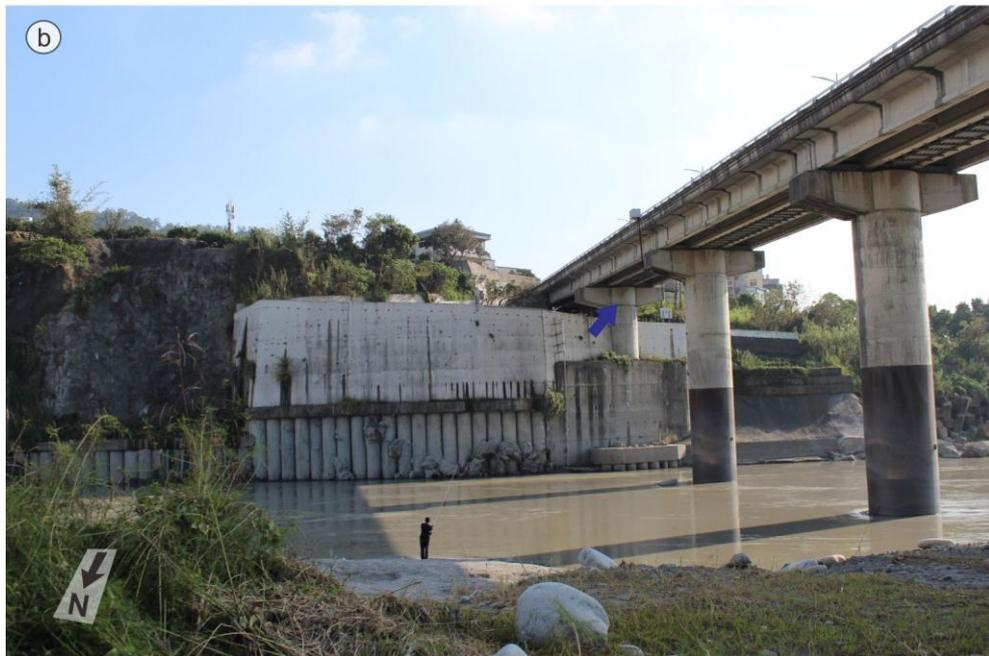
圖 51 大甲溪埤豐橋下河床同視角 17 年前後比較圖。(a)集集地震於大甲溪埤豐橋下的河床形成高差約 5 公尺的連續地形崖(黃文正 攝)；(b)現今已不見地形崖已後退，同一視角無法連續追蹤到地形崖。
