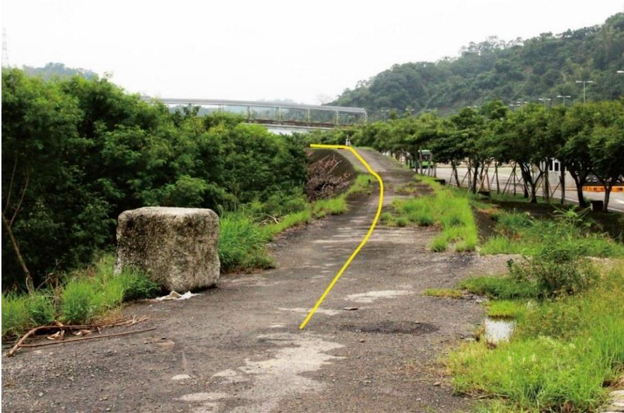
圖 43 乾溪南岸河堤。黃色線顯示野外使用經緯儀量測地形剖面的測線。
