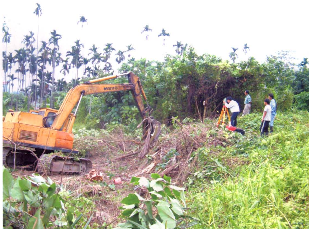
圖四 竹山槽溝的施工情形。地震地表的變形崖通過怪手的挖杓前方，怪手在相對降側，陳文山教授（站立在最遠處著藍白紋上衣）的團隊站立在相對升側進行地表地形測量。（陳文山提供，2002年11月攝）
