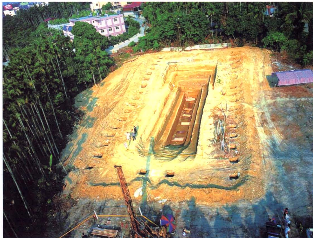
圖五 竹山槽溝的空照圖。此照片為朝東北方向拍得，槽溝開挖成四階，最上階僅佔槽溝的三分之一，亦為相對隆升側。於圖中即槽溝較遠的一端，此外槽溝底部另有一方坑，為土層的對比的目的而加挖。（陳文山提供）
