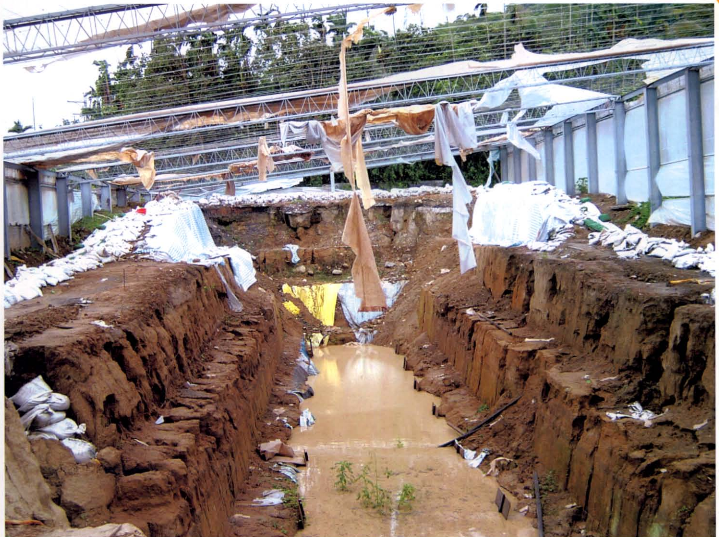
圖十七 颱風肆虐後的竹山槽溝。護棚遭強風吹破，雨水蓄積成池。
