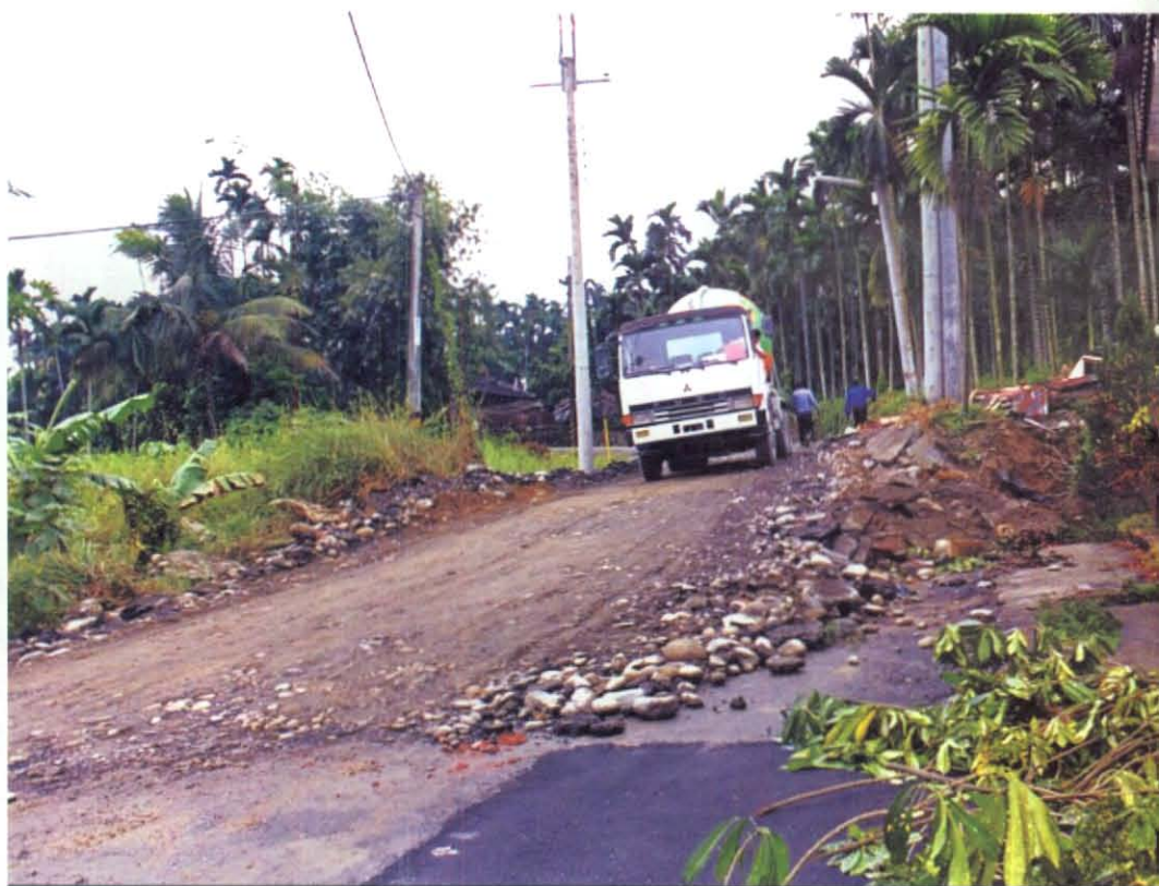
圖二 路面破裂及隆升，此位置在竹山槽溝東南方40米處，圖中右邊為竹林(1999年11月攝)
