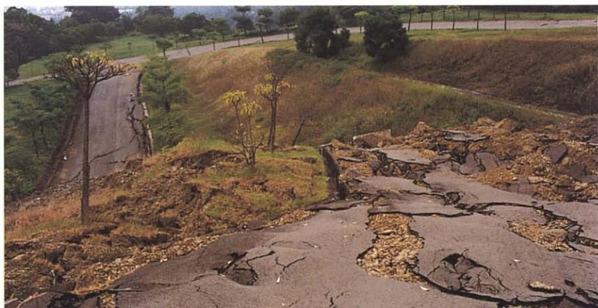
C. 一江橋東北方地面隆升，造成寬約10公尺之變形帶，垂直抬升量約8公尺，視水平左移約10公尺。
