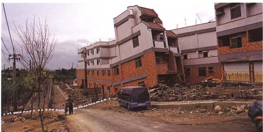
C. 原豐原鐵路改建之自行車道東側抬升，崖兩側高差約3.5公尺，視左移約5公尺。
