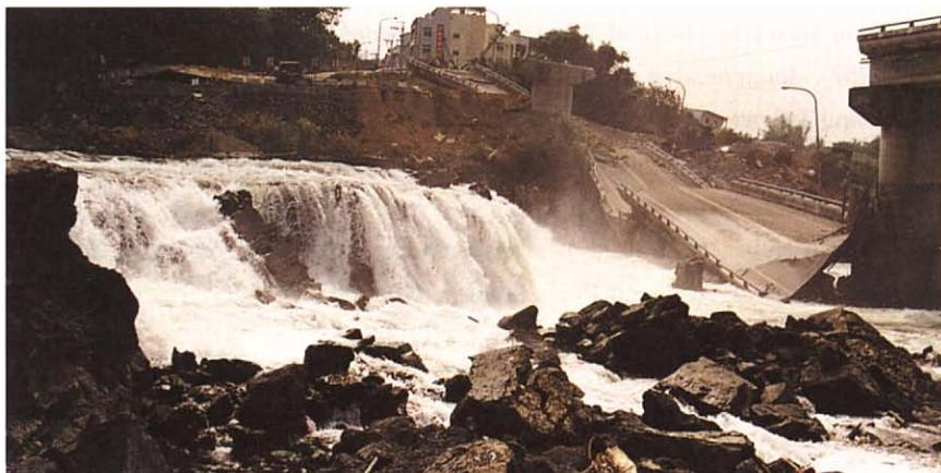
B. 大甲溪河床因岩層錯動形成斷層崖及瀑布，東側抬升，崖兩側高差約5公尺，右側坪豐橋錯斷。
