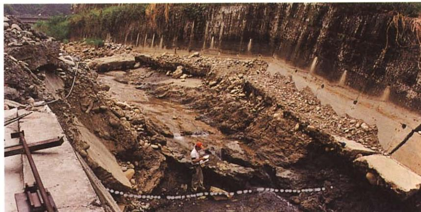
C. 烏牛欄溪河床抬升約0.9公尺，斷層滑動帶位於錦水頁岩內。
